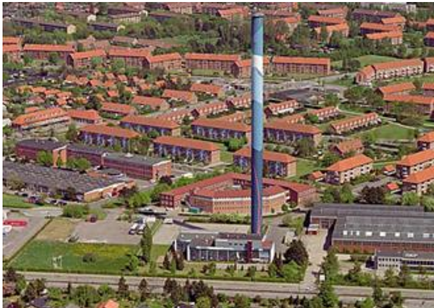
Varmecentral og administration i Brøndbyvester
