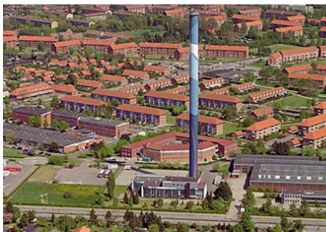
Varmecentral og administration i Brøndbyvester
