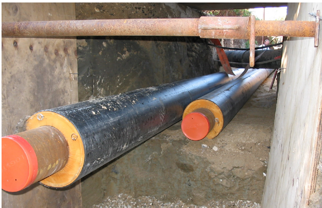
Udskiftning af fjernvarmeledninger
