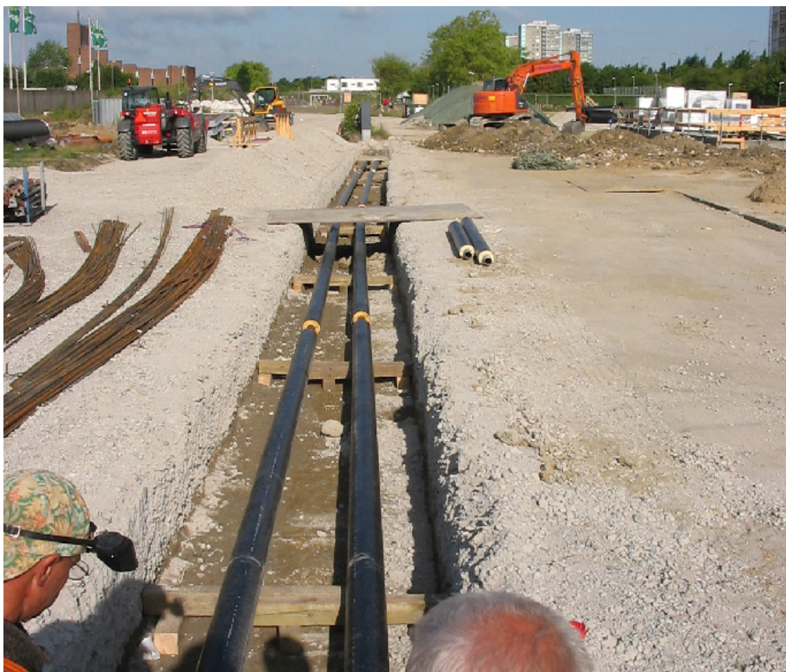
Ny ledning til det nye kulturhus i Brøndby Strand
