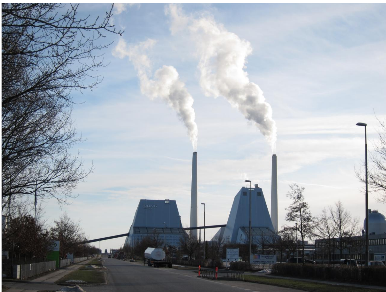
Avedøreværkets blok 1 og blok 2
