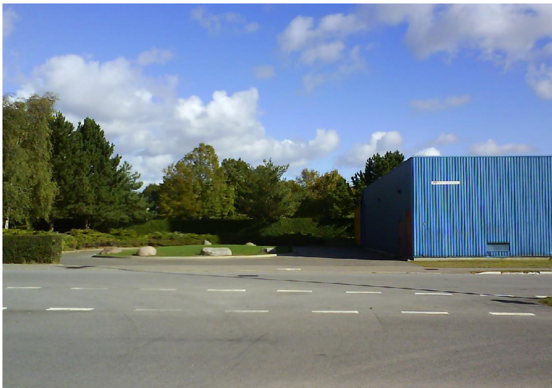
Varmecentralen i Brøndbyøster efter akkumulatortankene er blevet fjernet
