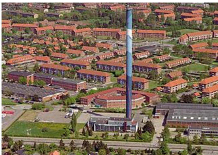
Varmecentral og administration i Brøndbyvester
