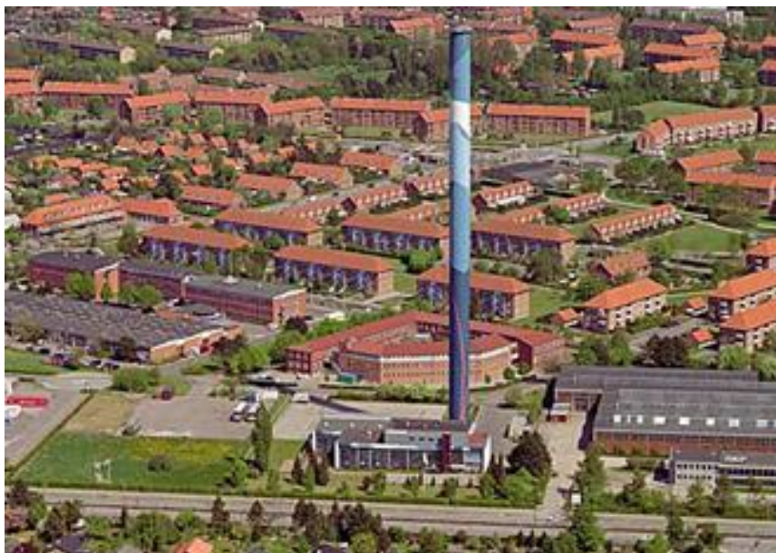
Varmecentral og administration i Brøndbyvester
