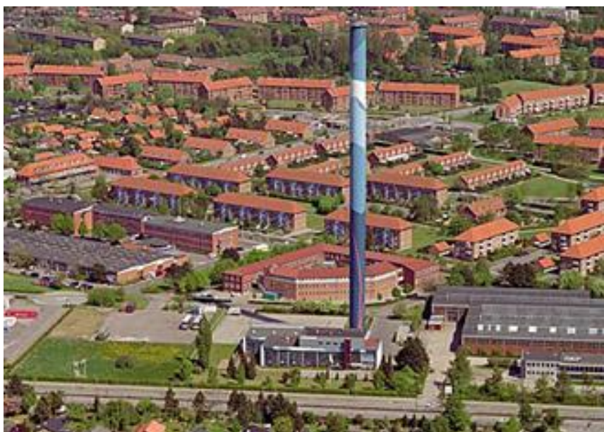
Varmecentral og administration i Brøndbyvester
