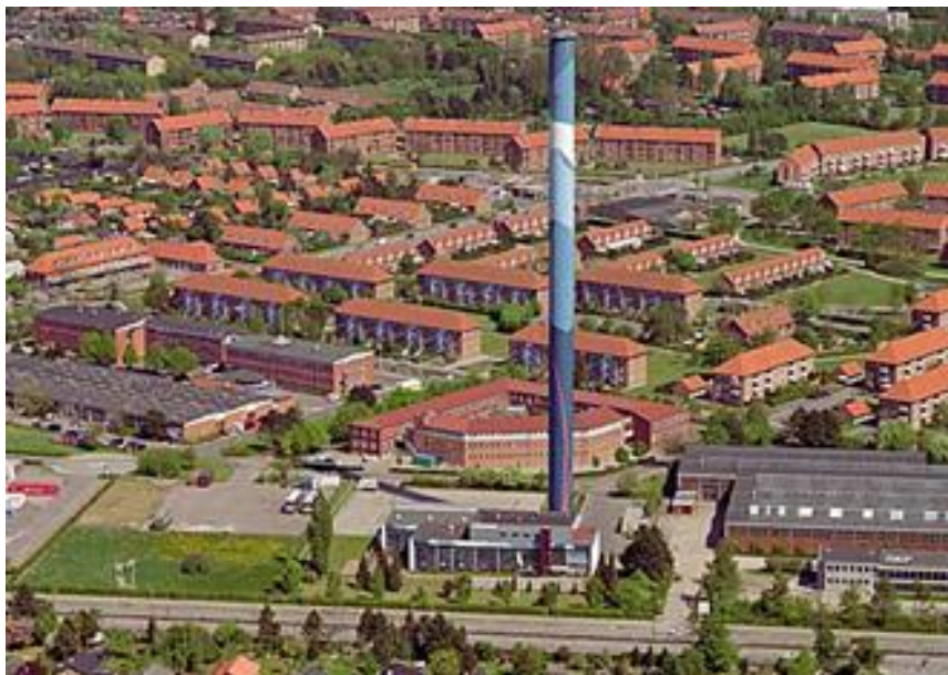
Varmecentral og administration i Brøndbyvester
