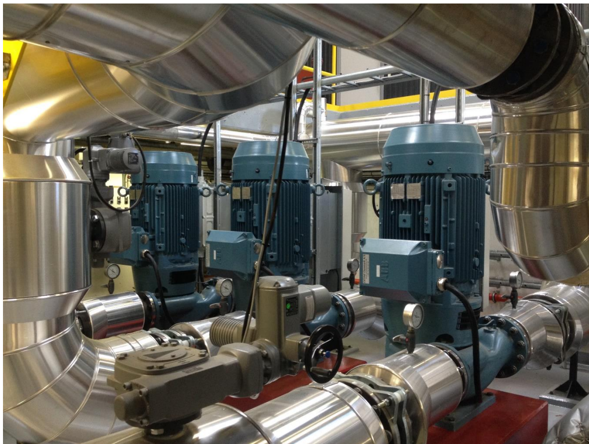
Nye distributionspumper på Østercentralen
