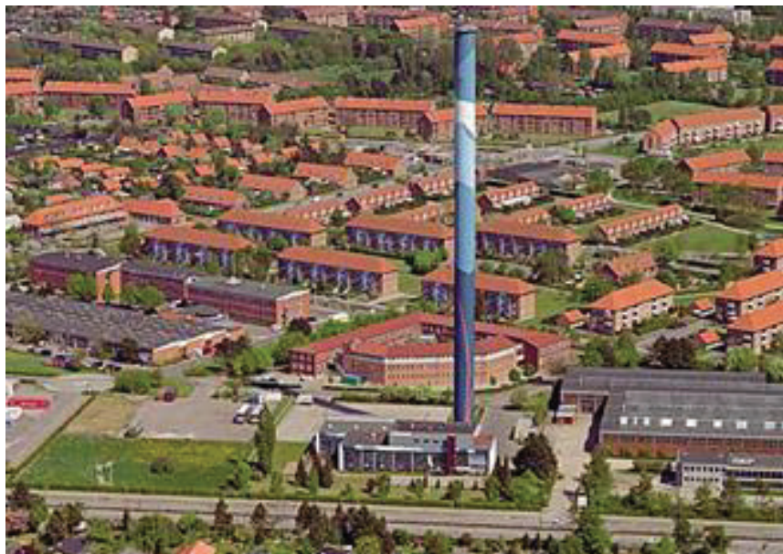
Varmecentral og administration i Brøndbyvester
