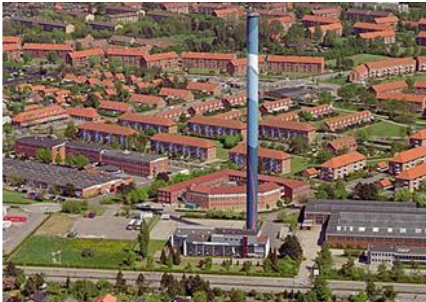
Varmecentral og administration i Brøndbyvester
