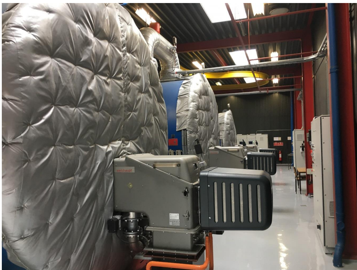
Nye brændere og Teknisk isolering af kedler, Brøndby Øster
