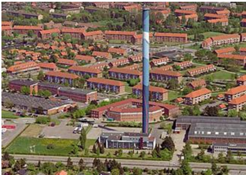
Varmecentral og administration i Brøndbyvester
