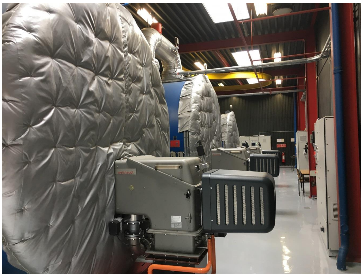
Nye brændere og Teknisk isolering af kedler, Brøndby Øster
